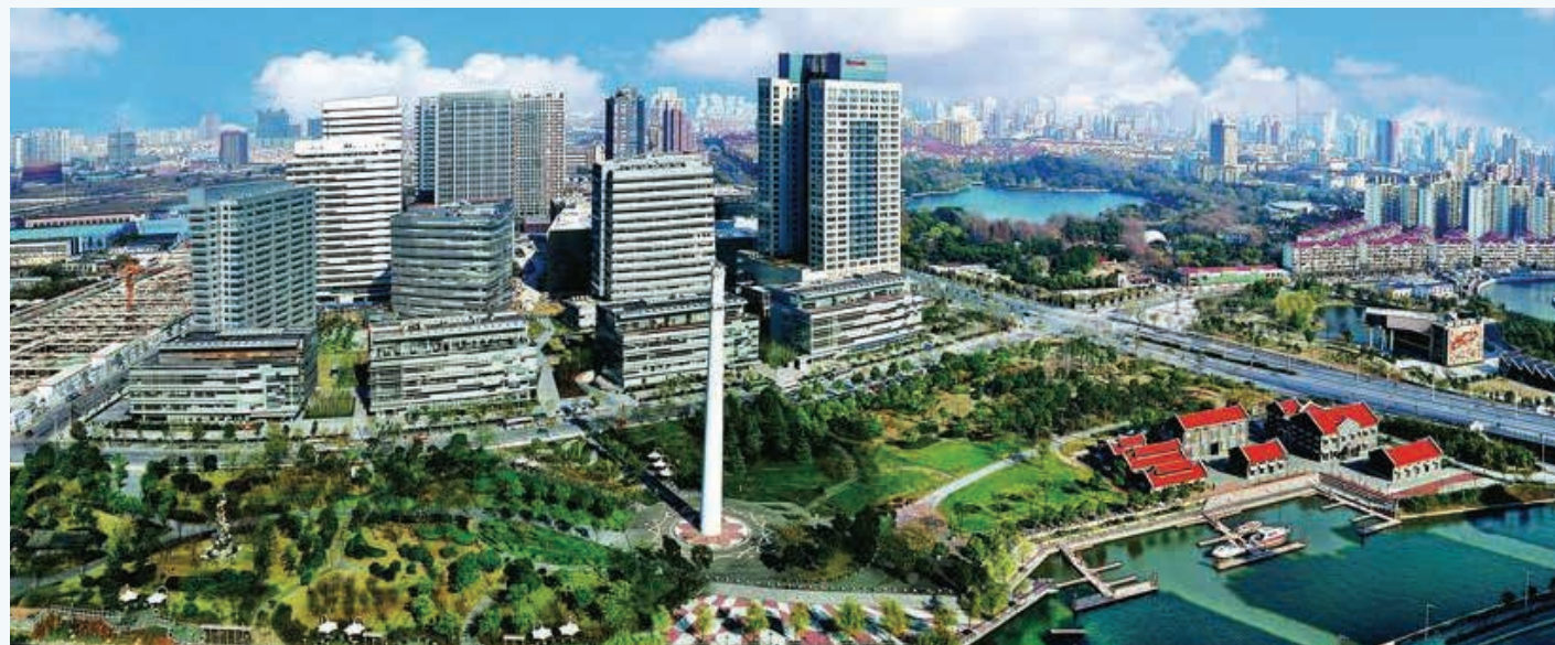
張江国家自主創新師範区が運営する上海普陀区にある工業団地の俯瞰図。(写真/チャイナデイリー)
