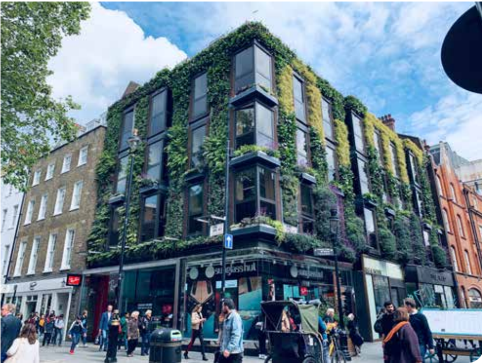
在结构基础上增加绿色外墙，有助于减少得热，保持室内温度适宜。
