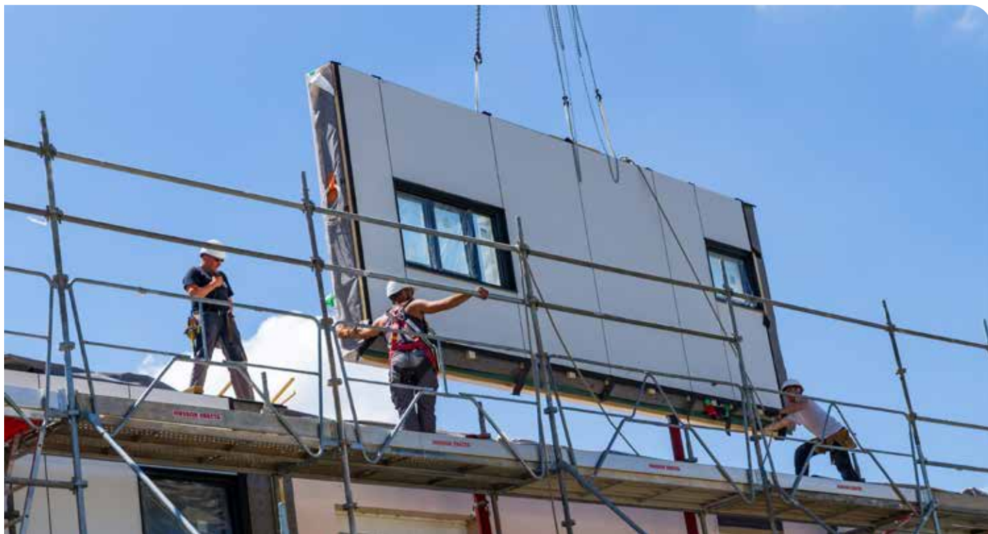
预制的保温板可以调节热量，加快更新改造进程。(Energiesprong 国际及 Fabrice Singevin)
