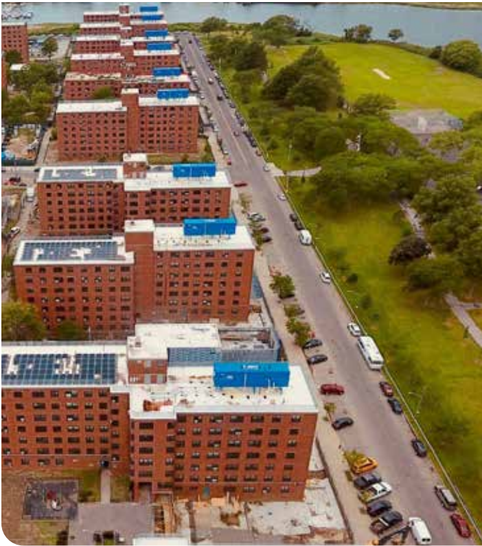
重新摆放的机械设备（蓝色）以及新的太阳能板（《NYCHA 抗洪韧性指南》）
