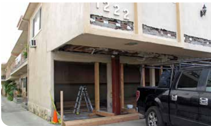
可通过增加力矩框架（红色柱）来加固软层。
