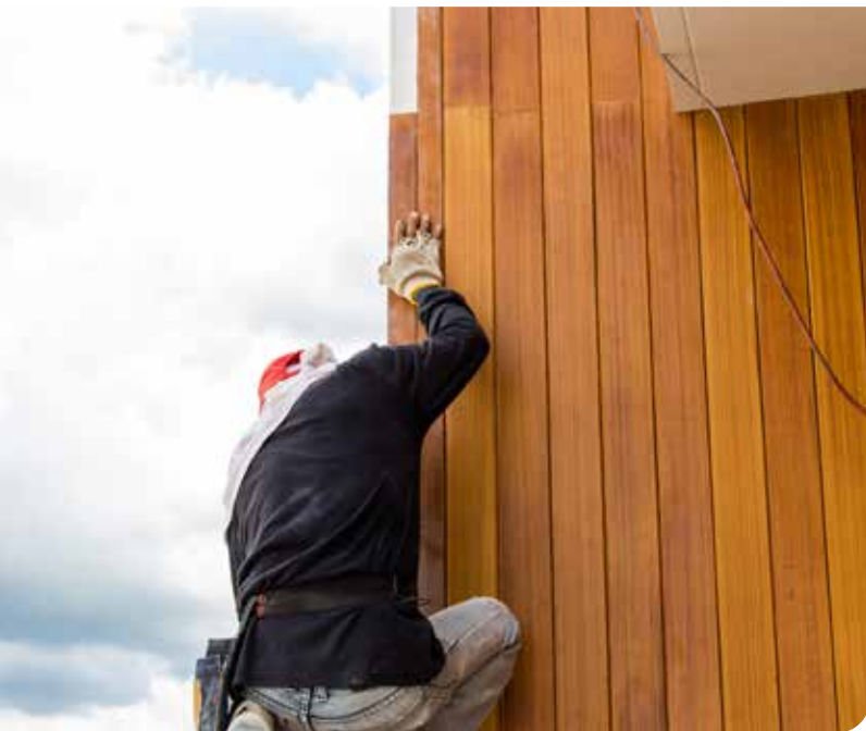
纤维质水泥壁板可呈现类似木材的效果，并提供防火性能（左图）；金属或瓦片也可防止屋顶着火（右图）。
