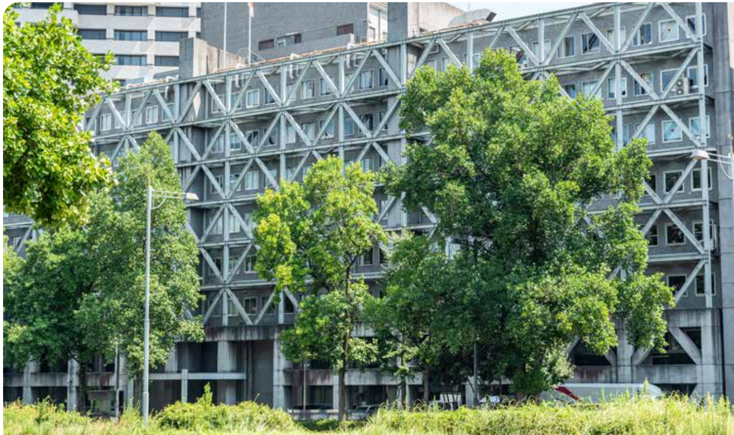
外部支撑能加固建筑,以应对地震风险。
