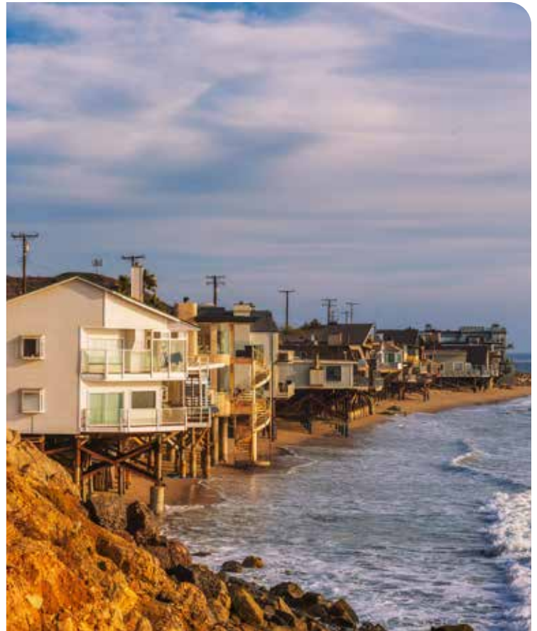
抬高沿海建筑是一种改造策略，可降低洪灾风险、减轻风暴潮的破坏。
