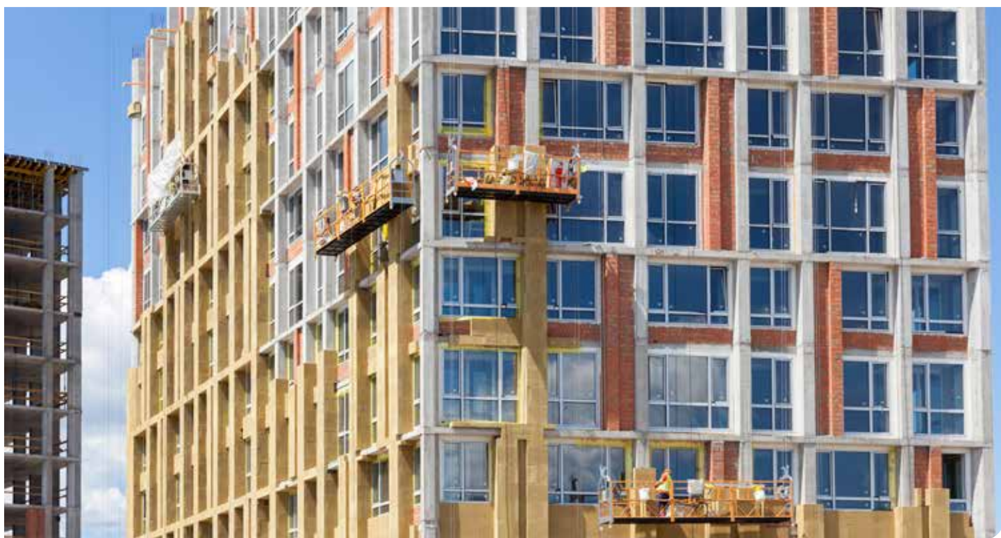
为外墙增添矿棉保温材料，以提高能源效率，也有利于热量管理。
