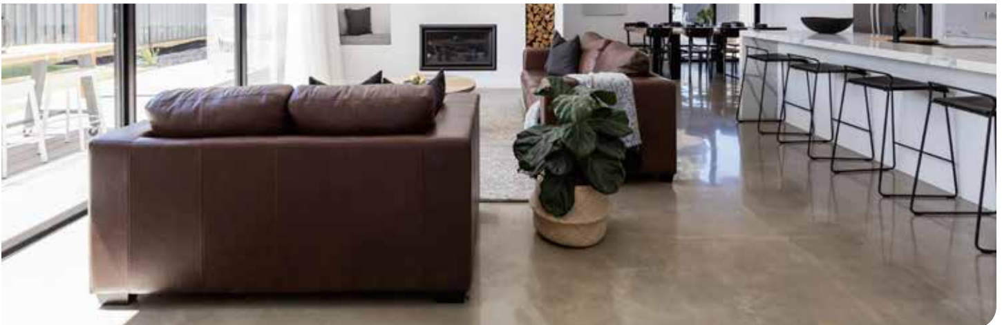
抛光混凝土地板等防水饰面颇具吸引力，且在洪水过后几乎无需维护。
